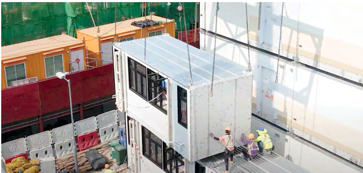
市建局於洪水橋過渡性房屋項目採用「組裝合成」建築法，帶來可持續發展的裨益。
