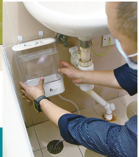
「創意工程及建築設計比賽」金獎設計「U型隔氣彎管自動補水器」的得獎團隊（左圖）。該設計經改良及測試後將裝設於市建局的安置大廈及部分已收購的物業（下圖）。
