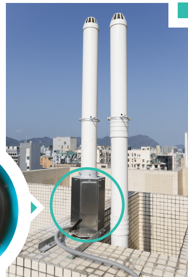
於鼓油街安置大廈的天台通風管上安裝智能通風管淨化器。
