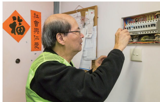
余師傅義務維修保險電箱。 Master Yu helps fix the fuse box.
