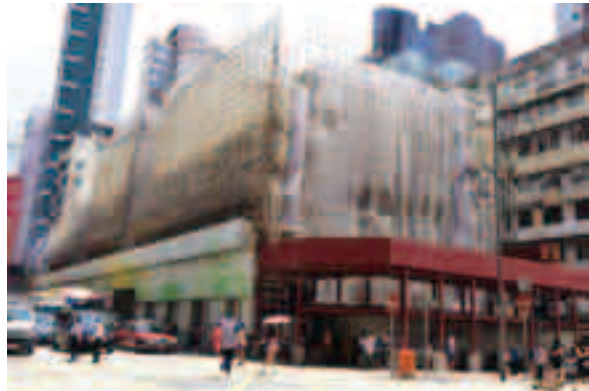
上海街／亞皆老街保育項目正進行上層結構工程。
