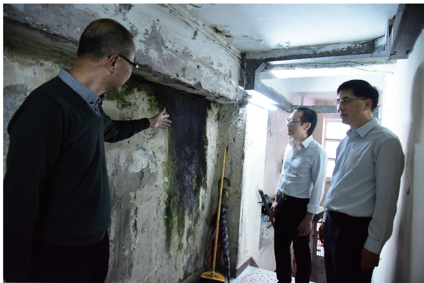
於項目啟動當日與市建局職員視察橡樹街／埃華街發展項目，了解殘破失修樓宇的狀況。
