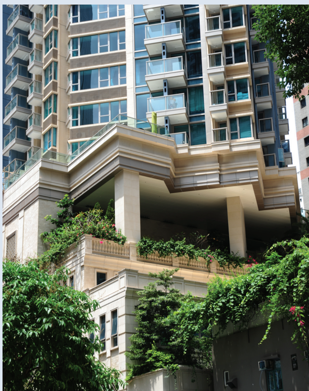
■ 利東街／麥加力歌街項目的工程已接近完成。
