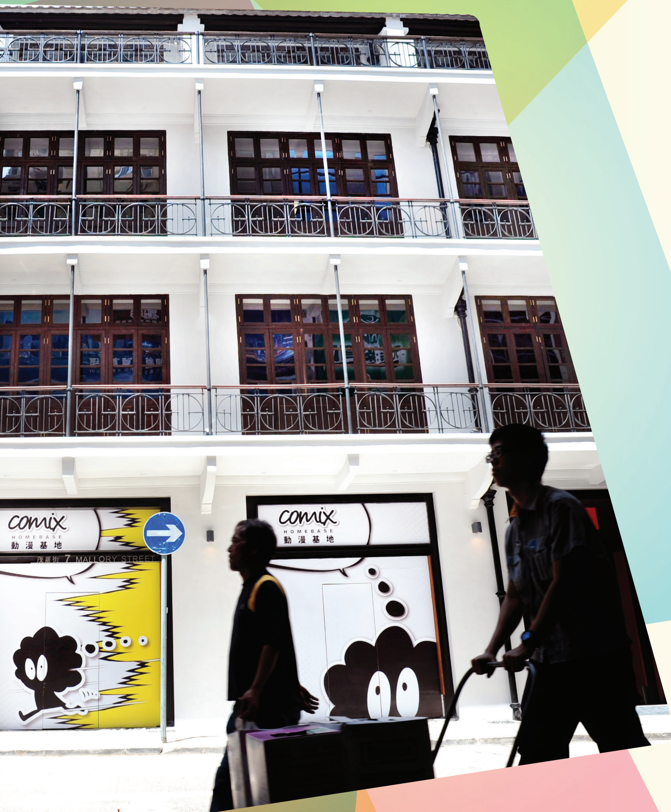
市建局茂蘿街／巴路士街活化項目「動漫基地」。
