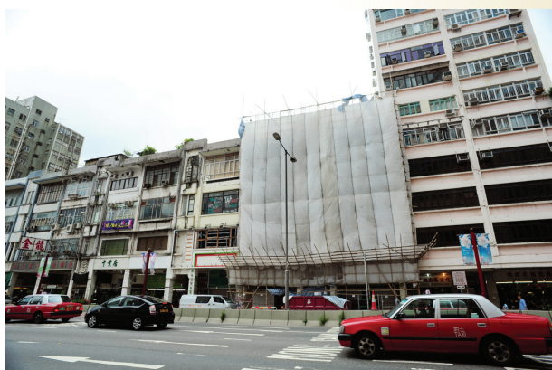
市建局在太子道西項目內兩幢已收購的樓宇進行保育復修工程。
