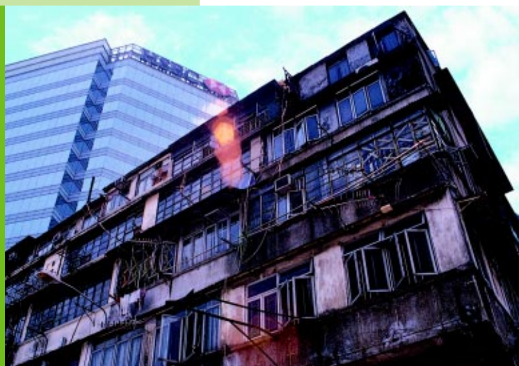
大角嘴櫻桃街重建項目。 Redevelopment project at Cherry Street, Tai Kok Tsui.
