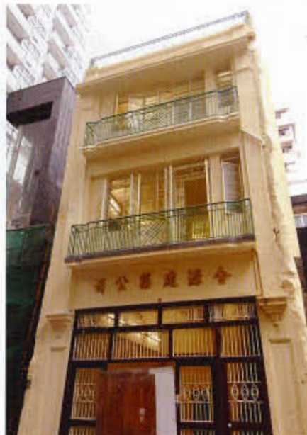
位於船街18號的一幢唐樓翻新後展新貌。 A shophouse at 18 Ship Street after refurbishment.
