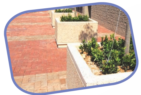
大角嘴櫻桃街重鋪行人路及加入綠化元素。
