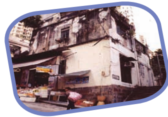
餘樂里一至二號唐樓部分的遺跡及建築元素會予以保留。
