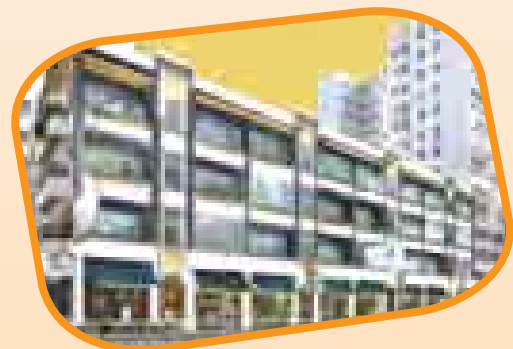
位於太子道西一組十幢具有顯著文物價值的戰前建築群將被保育活化。
