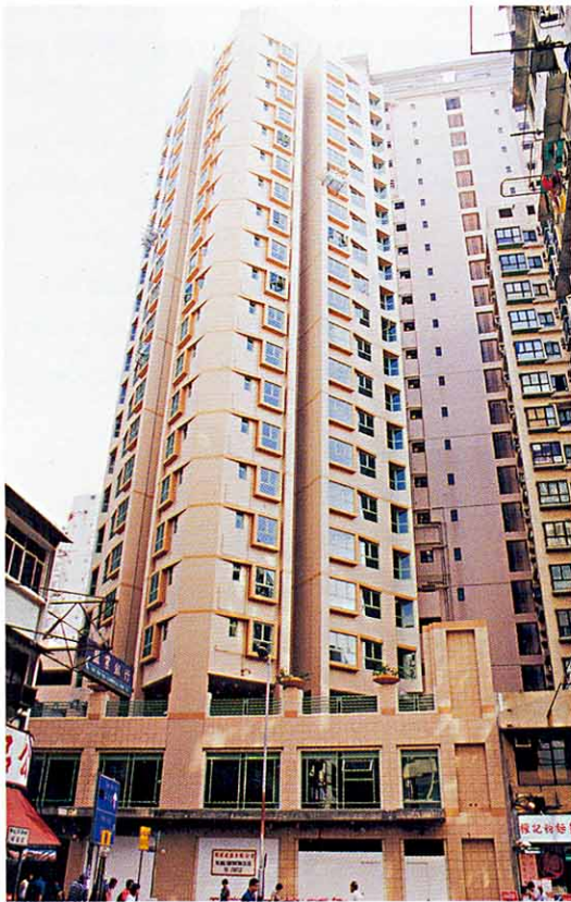
紅磡寶其利街重建項目 (寶康閣)。 The Bulkeley Street redevelopment (Bulkeley Court) in Hung Hom.
